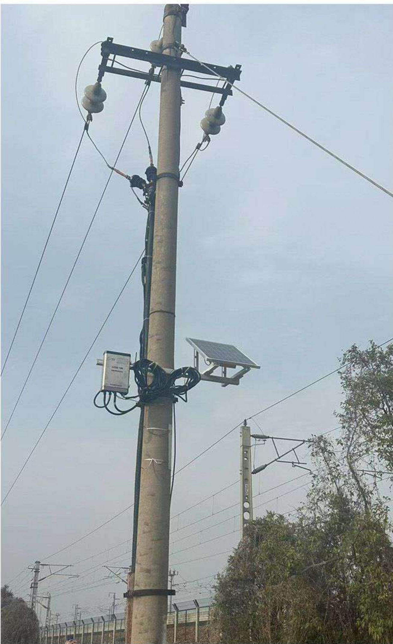
自闭贯通线设备终端杆塔安装示意图
